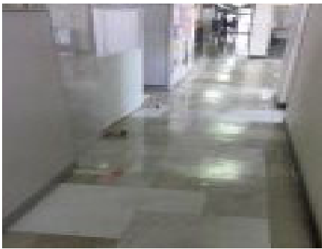
図 25 狭あいな通路
